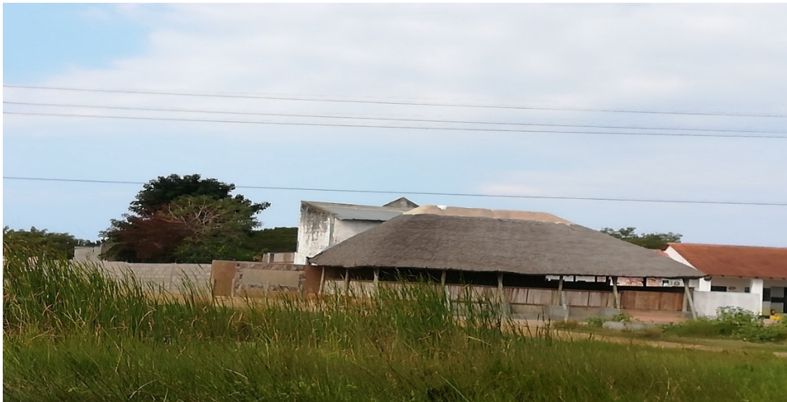
A caminho da Praia da Macaneta deparamo-nos com vários aldeamentos bem arrançados.
