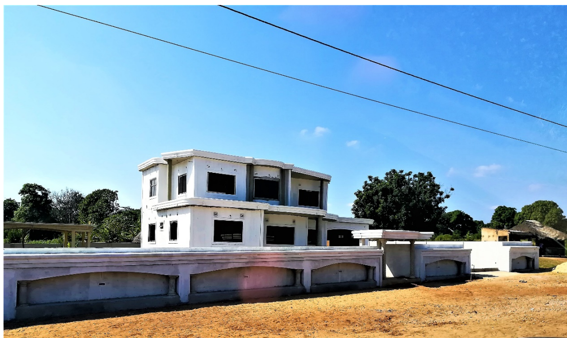
Uma habitação em construção em Macia.
